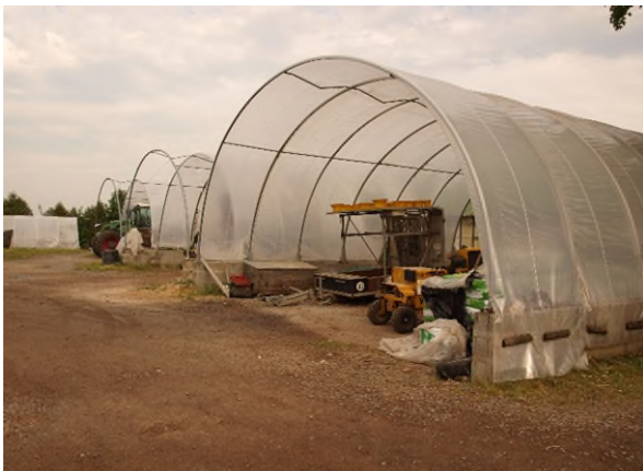
Folienhallen und versiegelte Hofflächen im zentralen Teil des Plangebietes, Blick nach Westen
