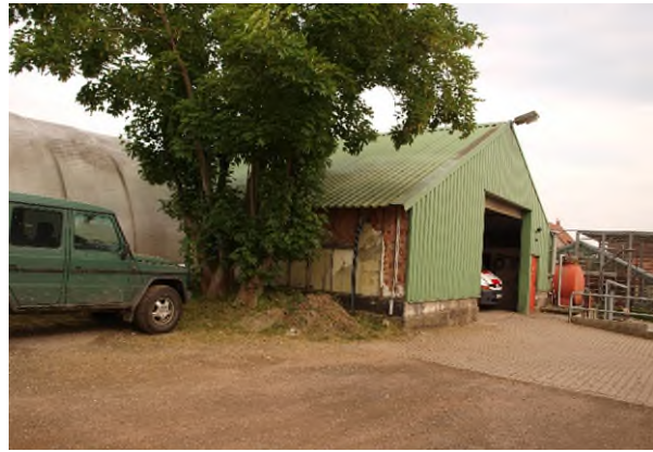
Werkstattgebäude mit Einzelbäumen und versiegelte Hoffläche im zentralen Teil des Plangebietes, Blick nach Südwesten
