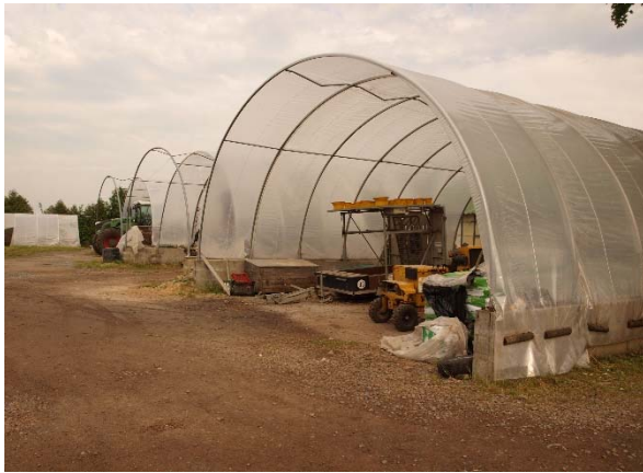
Folienhallen und versiegelte Hofflächen im zentralen Teil des Plangebietes, Blick nach Westen
