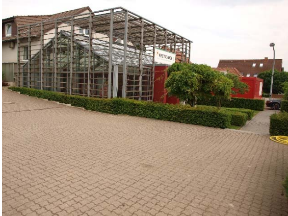
Bestehendes Wohn-/Bürogebäude im Süden des Plangebietes, Blick nach Westen
