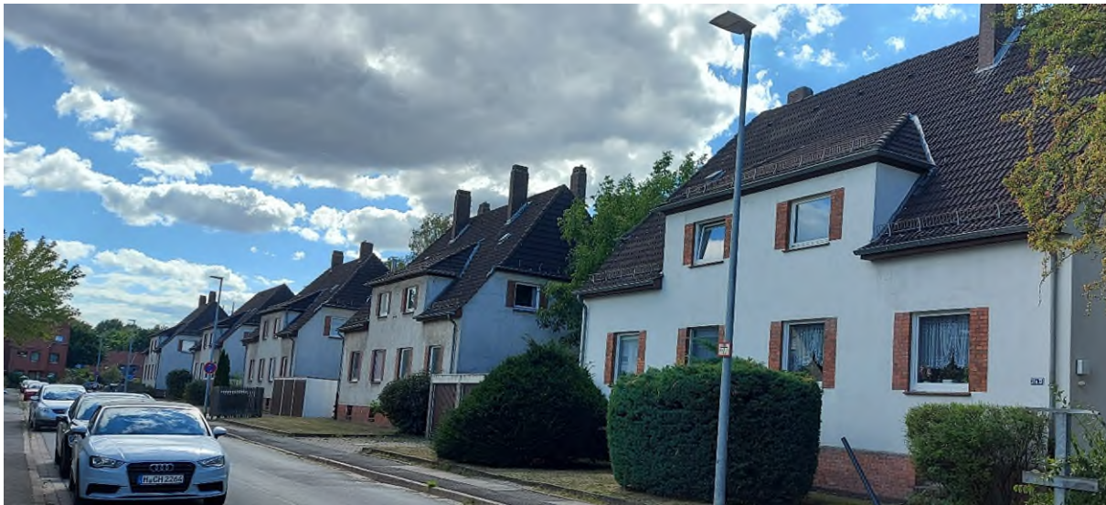
Abbildung 6: Foto der Bestandsbebauung an der Kapellenstraße
